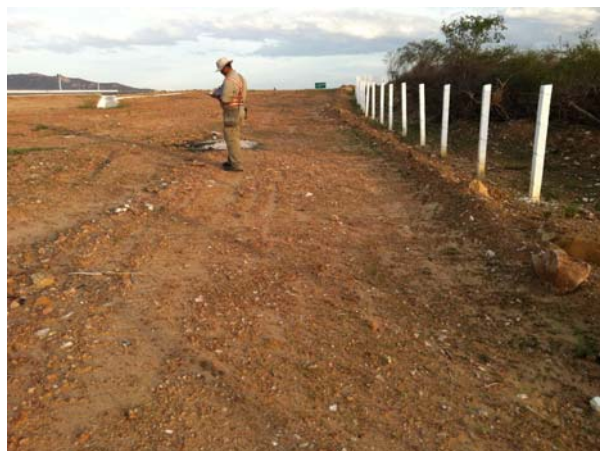
Legenda Foto 2893 (SE) Documentação da faixa de domínio com intervenções antrópicas.
