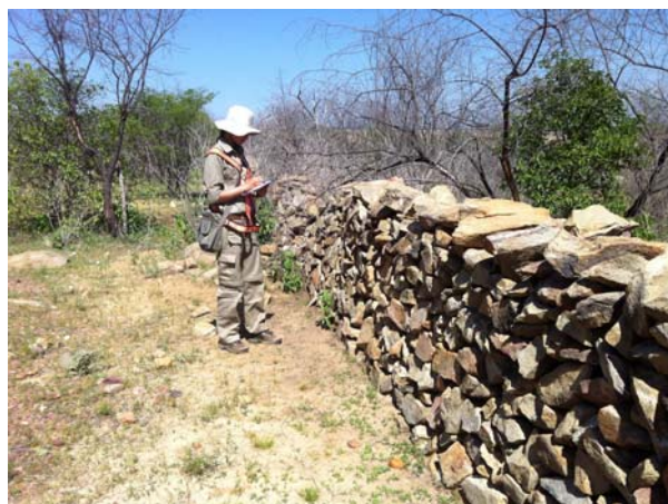
Legenda Foto 2917 (NW) Muro de pedra 100m da ADA e prospecção com afloramentos rochosos.
