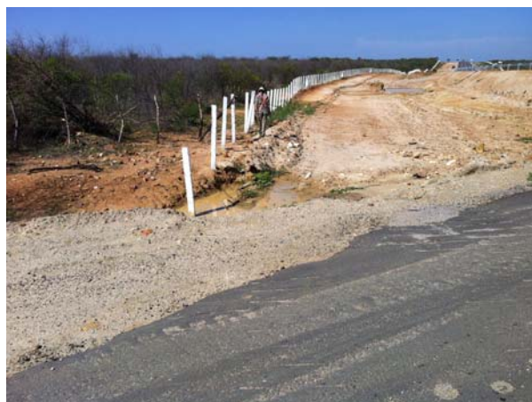
Legenda Foto 2907 (SW) Área de empréstimo cortado por máquina na AID Caatiga com regular visualização da superfície sem interferência antrópicas. ADA e AID e AD
