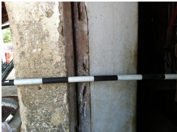
FIGURA 148- DETALHE DA ESPESSURA DA PAREDE DA RESIDÊNCIA, QUE MEDE 0,50M DE LARGURA. PONTO: BR427-111. FONTE: ACERVO ARQUEOLOG PESQUISAS, 2014.
