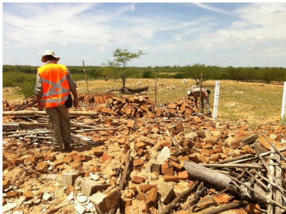
FIGURA 123- A EDIFICAÇÃO ESTÁ LOCALIZADA NO LIMITE DA FAIXA DE DOMÍNIO. PONTO: BR-427-033. FONTE: ACERVO ARQUEOLOG PESQUISAS, 2014.
