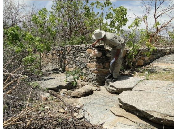
FIGURA 79- DETALHE DA EDIFICAÇÃO EM PEDRAS, COM INTERVENÇÕES REALIZADAS COM MATERIAL CONSTRUTIVO RECENTE. FONTE: ACERVO ARQUEOLOG PESQUISAS, 2014.
