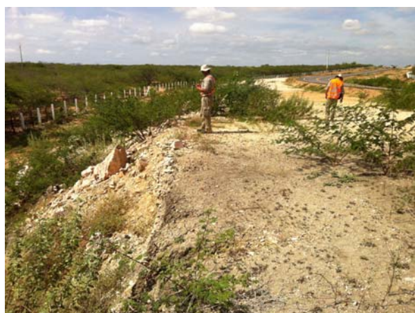
Legenda Foto 2801 (SW) Documentação de área aterrada na faixa de domínio e com presença de local alagado no limite de faixa.
