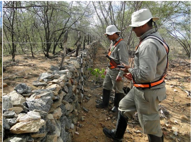
FIGURA 100- CERCA DE PEDRA EDIFICADA RECENTEMENTE COM UTILIZAÇÃO DE ESTACAS DE MADEIRA E ARAME FARPADO. PONTO: BR427-008.
