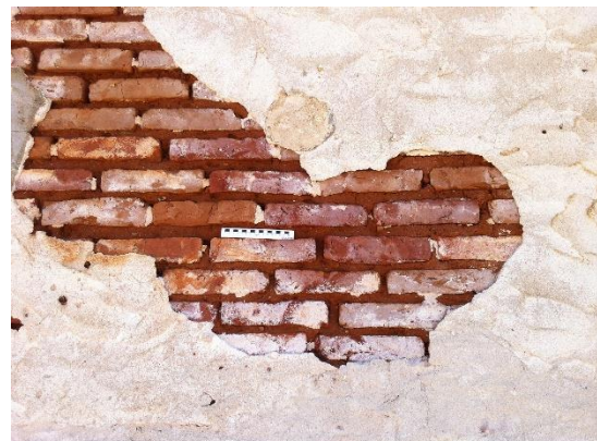
FIGURA 139- DETALHE DO MATERIAL CONSTRUTIVO. TIJOLOS BATIDOS COM ARGAMASSA DE BARRO, REBICADA COM CIMENTO PORTLAND. PONTO: BR427-087. FONTE: ACERVO ARQUEOLOG PESQUISAS, 2014.
