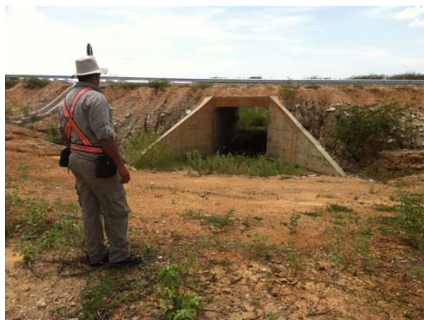
Legenda Foto 2862 (SW) Prospecção visual em área rebaixada, onde foi edificada passagem de água na área da rodovia.
