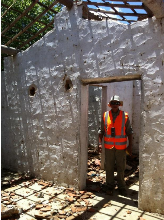
FIGURA 136- ÁREA INTERNA DA EDIFICAÇÃO (SALA). PONTO: BR427-087. FONTE: ACERVO ARQUEOLOG PESQUISAS, 2014.
