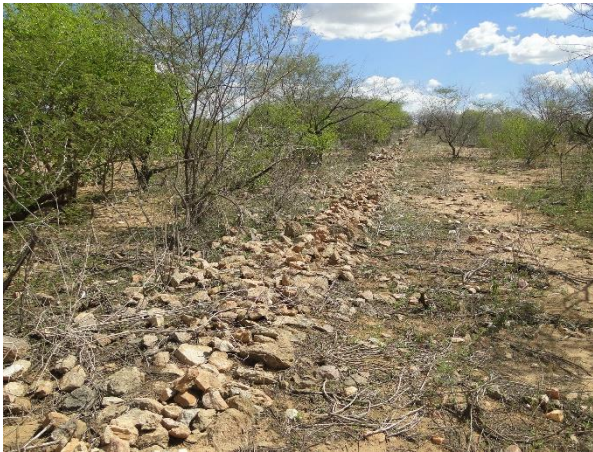
FIGURA 99- CERCA DE PEDRA DESTRUÍDA NA AID DO CONTORNO RODOVIÁRIO. PONTO: BR427-006. ORIENTAÇÃO: NE.
