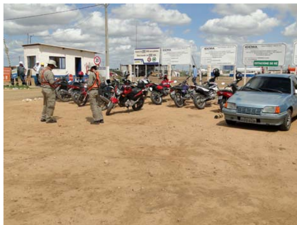
Legenda Foto 4064 (W) Canteiro de obras do Consórcio Caicó (Empresas Toniolo e Brusnello)
