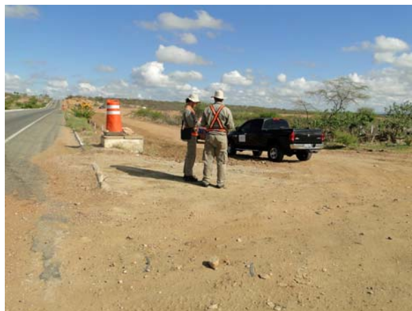
Legenda Foto 4057 (NW) Prospecção de superfície na área do contorno rodoviário. Presença de afloramentos rochosos.
