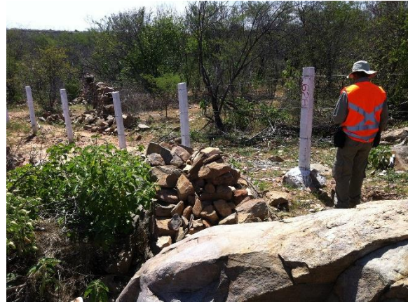
FIGURA 98- CERCA DE PEDRA INTERROMPIDA PELAS OBRAS DO CONTORNO RODOVIÁRIO. PONTO: BR427-071. ORIENTAÇÃO: SE.
