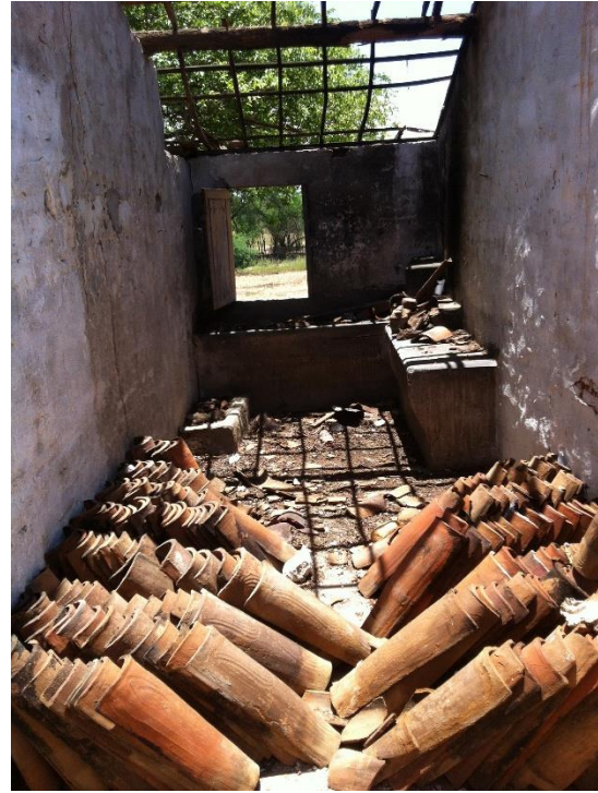
FIGURA 137- COZINHA DA EDIFICAÇÃO, ONDE EXISTE ESTRUTURA DE APOIO AO FORNO À LENHA. PONTO: BR427-087. FONTE: ACERVO ARQUEOLOG PESQUISAS, 2014.
