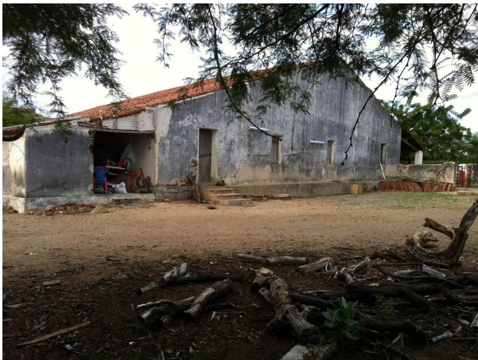
FIGURA 145- LATERAL ESQUERDA DA EDIFICAÇÃO. PONTO: BR427-111. FONTE: ACERVO ARQUEOLOG PESQUISAS, 2014.
