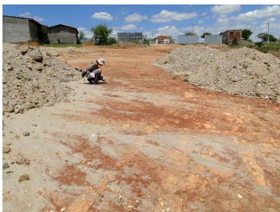
FIGURA 111- IDENTIFICAÇÃO DE VESTÍGIO DE EDIFICAÇÃO EM ÁREA DECAPITADA POR AÇÃO DE MÁQUINAS. PONTO BR427-002. FONTE: ACERVO ARQUEOLOG PESQUISAS, 2013.
