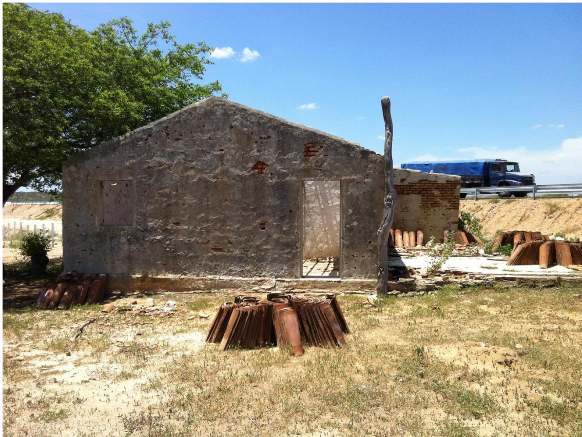
FIGURA 135- PANORÂMICA DA EDIFICAÇÃO EM RELAÇÃO À RODOVIA. PONTO: BR427-087. FONTE: ACERVO ARQUEOLOG PESQUISAS, 2014.
