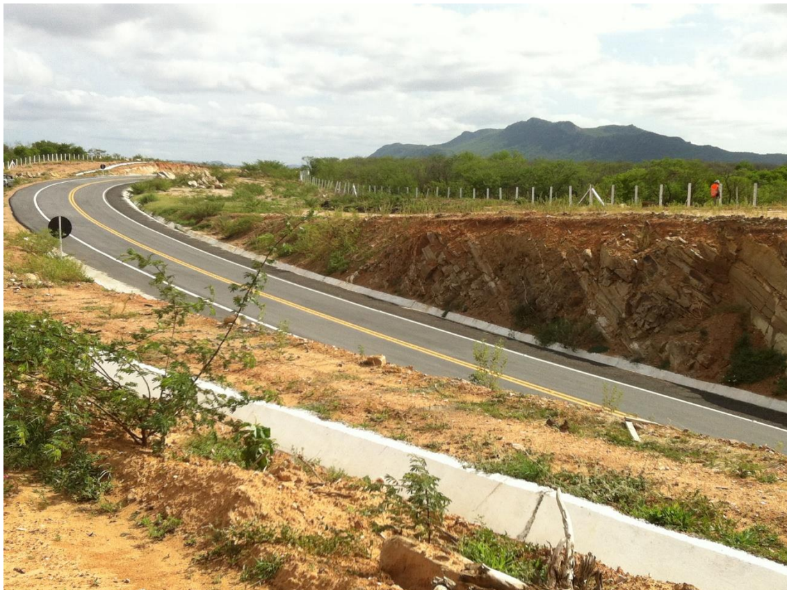
FIGURA 87- CONTORNO RODVIÁRIO DE BR-427 EDIFICADO E COM CERCAS IMPLANTADAS NO LIMITE DA FAIXA DE DOMÍNIO. PONTO BR427-024. ORIENTAÇÃO: NE. FONTE: ACERVO ARQUEOLOG PESQUISAS, 2014.
