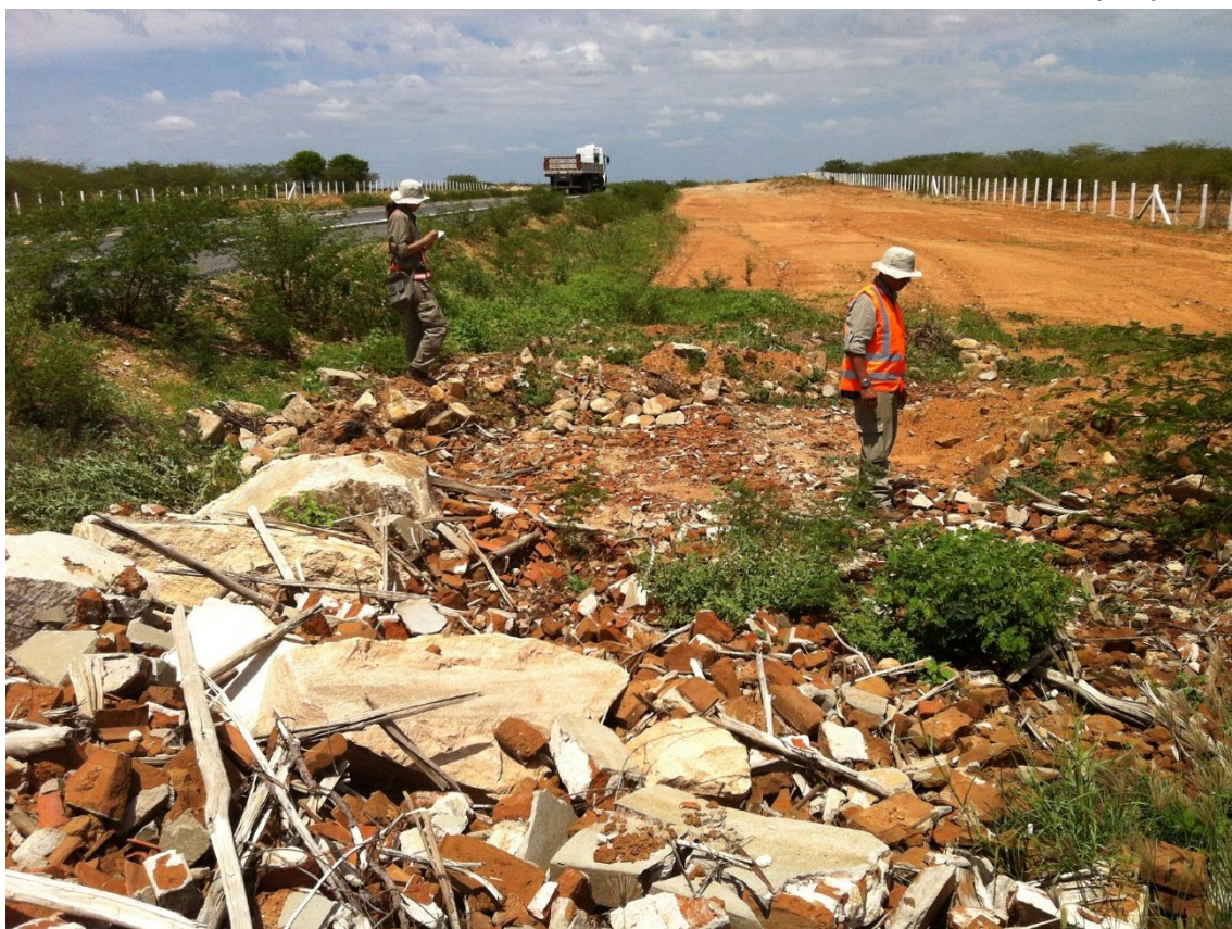
FIGURA 127- ENTULHO DE CONSTRUÇÃO IDENTIFICADO NA MARGEM DIREITA DO CONTORNO RODOVIÁRIO. PONTO: BR427-036. FONTE: ACERVO ARQUEOLOG PESQUISAS, 2014.
