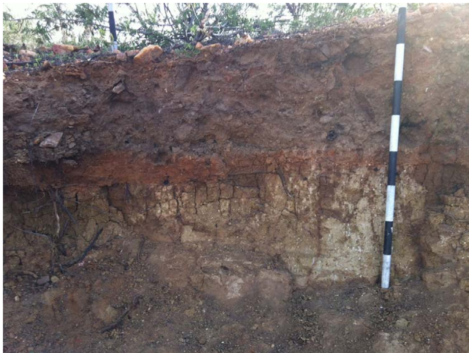
Foto Perfil: IMG_3215.JPG Orientação : SW
