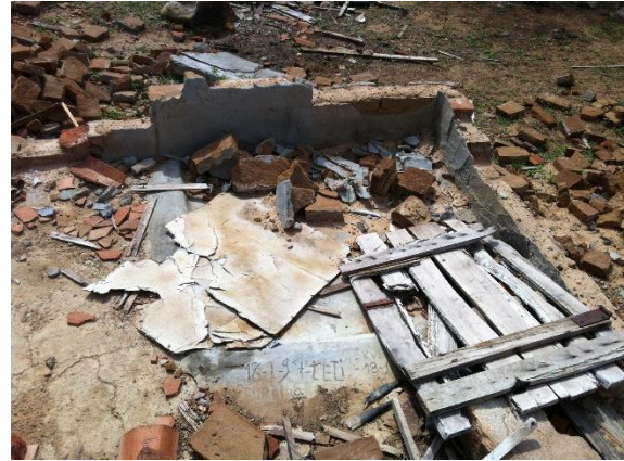
FIGURA 117- BANHEIRO DA RESIDÊNCIA ONDE É POSSÍVEL OBSERVAR NO PISO INSCRIÇÕES REALIZADAS PELO PEDREIRO NO ANO DE 1997 INSCRITO EM RELEVO. PONTO: BR427-030. ORIENTAÇÃO: E. FONTE: ACERVO ARQUEOLOG PESQUISAS, 2014.
