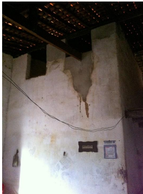
FIGURA 153- PAVIMENTO SUPERIOR DA RESIDÊNCIA. PONTO: BR427-111. FONTE: ACERVO ARQUEOLOG PESQUISAS, 2014.
