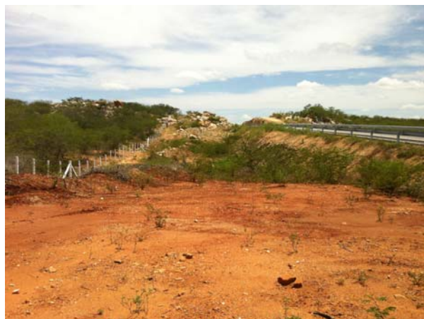
Legenda Foto 2860 (SE) Prospecção no limite da faixa de domínio em local com bastante afloramentos rochosos.
